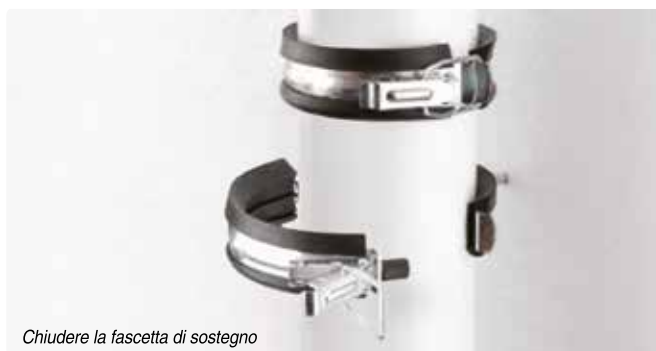
Installazione del tubo
